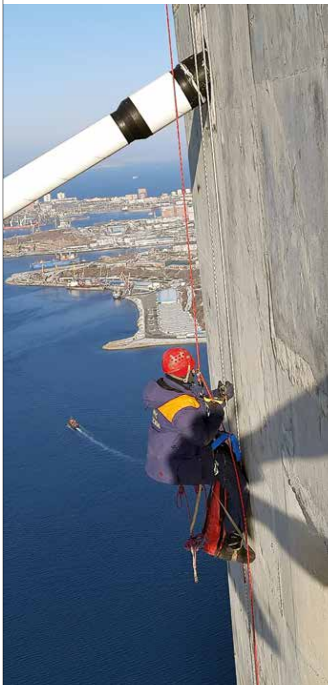
При работах на высоте необходимо соблюдать требования безопасности
